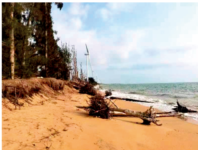
图 39 海南东方华能电厂南侧岸段海岸侵蚀 拍摄时间 20230315; 坐标 19.04°N, 108.64°E
