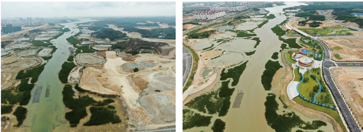
广西壮族自治区钦州市孔雀湾海洋生态保护修复效果（左图：修复前，右图：修复后）
